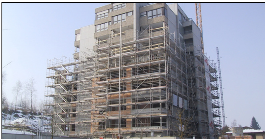
Rückbau Hochhaus bis auf den Rohbau, 1.- 6. OG. mit neuen Wohnungen im Rohbau fertig, 7. - 9. OG. noch im alten Zustand. Foto P. Ulrich
